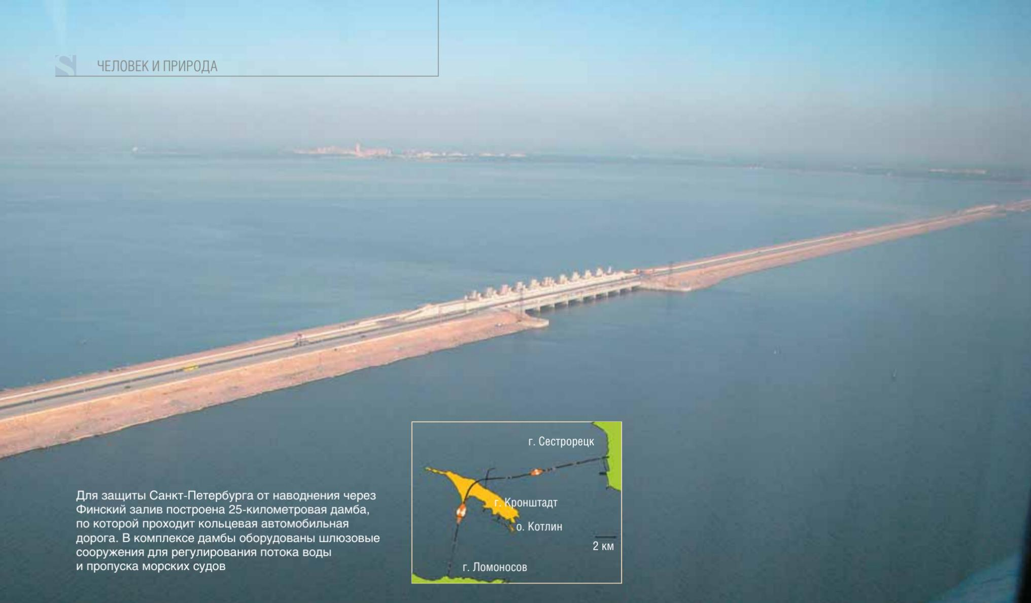
Для защиты Санкт-Петербурга от наводнения через Финский залив построена 25-километровая дамба, по которой проходит кольцевая автомобильная дорога. В комплексе дамбы оборудованы шлюзовые сооружения для регулирования потока воды и пропуска морских судов
